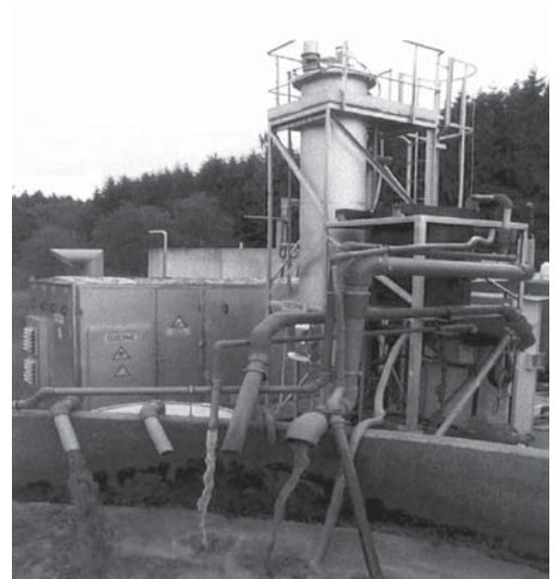
Figure 1 : Représentation de la boucle Biolysis directement installée au niveau du bassin biologique
