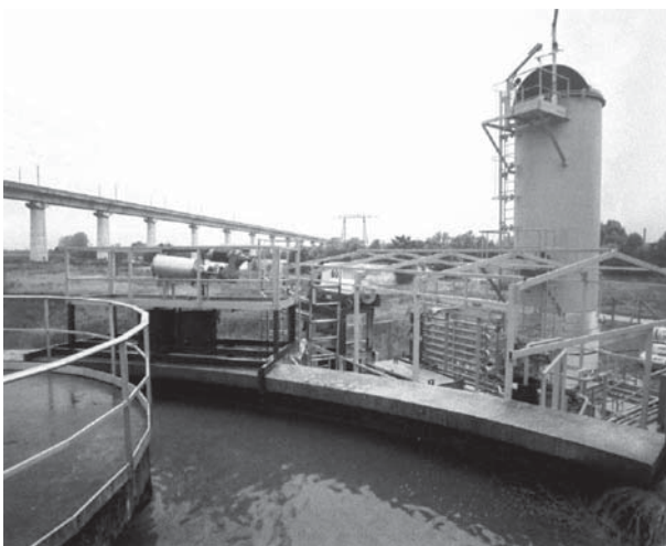
Photographie 2 : prototype du procédé Biolysis E installé sur la station d'épuration de Verberie 3000 eq-hab
