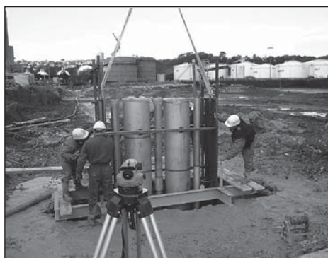
Figure 9. Mise en place de la porte filtrante
