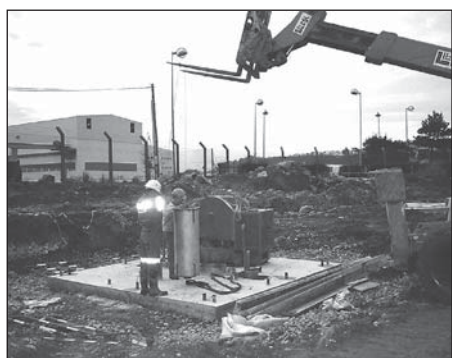
Figure 10. Remplacement d'un filtre
