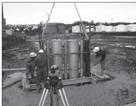
Figure 9. Mise en place de la porte filtrante
