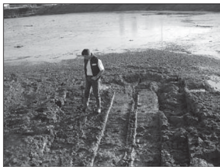
8. Aspect du matériau après stabilisation in situ
