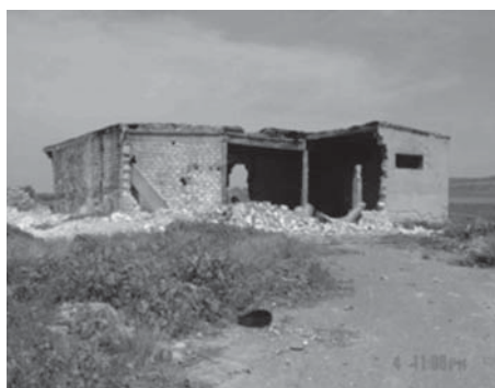
Figure 3 : Dépôt de stockage de Glodeni
