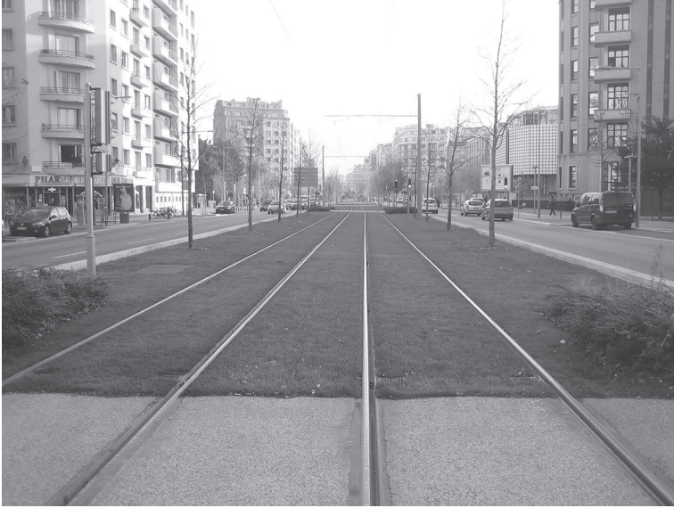
Photo 3 : Les Grands Boulevards, Grenoble.
