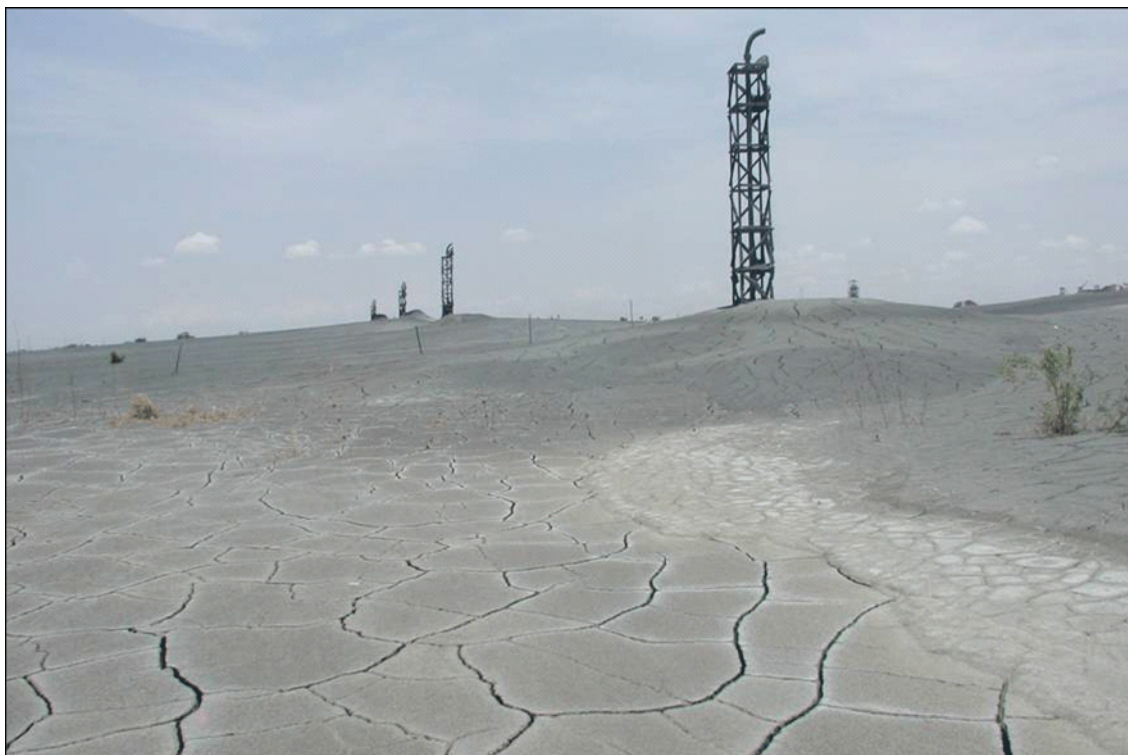
Figure 3 : Photographie montrant le DPS à la mine de Bulyanhulu, Tanzanie (Octobre 2004, photo Vincent Martin).
