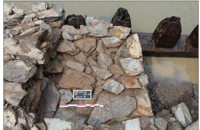
Fig. 9 – Détail du chaînage du remplissage avec les hourdis (cliché : T. Maisonneuve).
