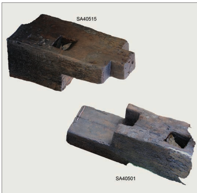
Fig. 20 – Axonométrie de l'enture droite à tenon-mortaise des sablières SA40515-SA40501 (DAO : F. Épaul).
