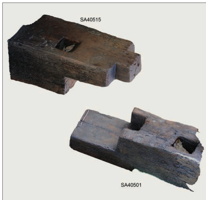
Fig. 20 – Axonométrie de l'enture droite à tenon-mortaise des sablières SA40515-SA40501 (DAO : F. Épaul).
