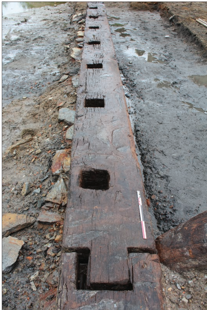
Fig. 18 – Assemblage de croisée droite à mi-bois de l'angle nord-ouest du caisson n° 9 (cliché : F. Épaul).
