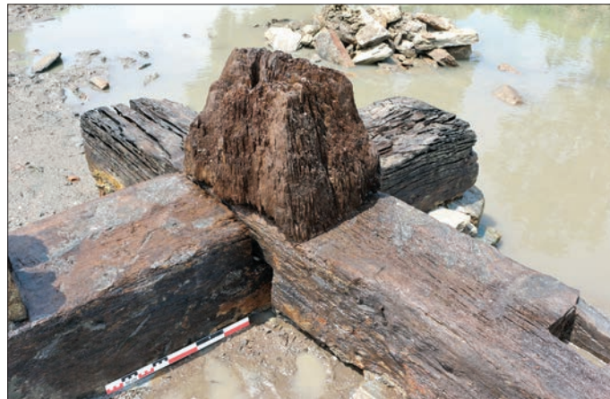
Fig. 17 – Alignement des mortaises de la sablière SA40501, en façade nord du caisson n° 9 (cliché : F. Épaud).
