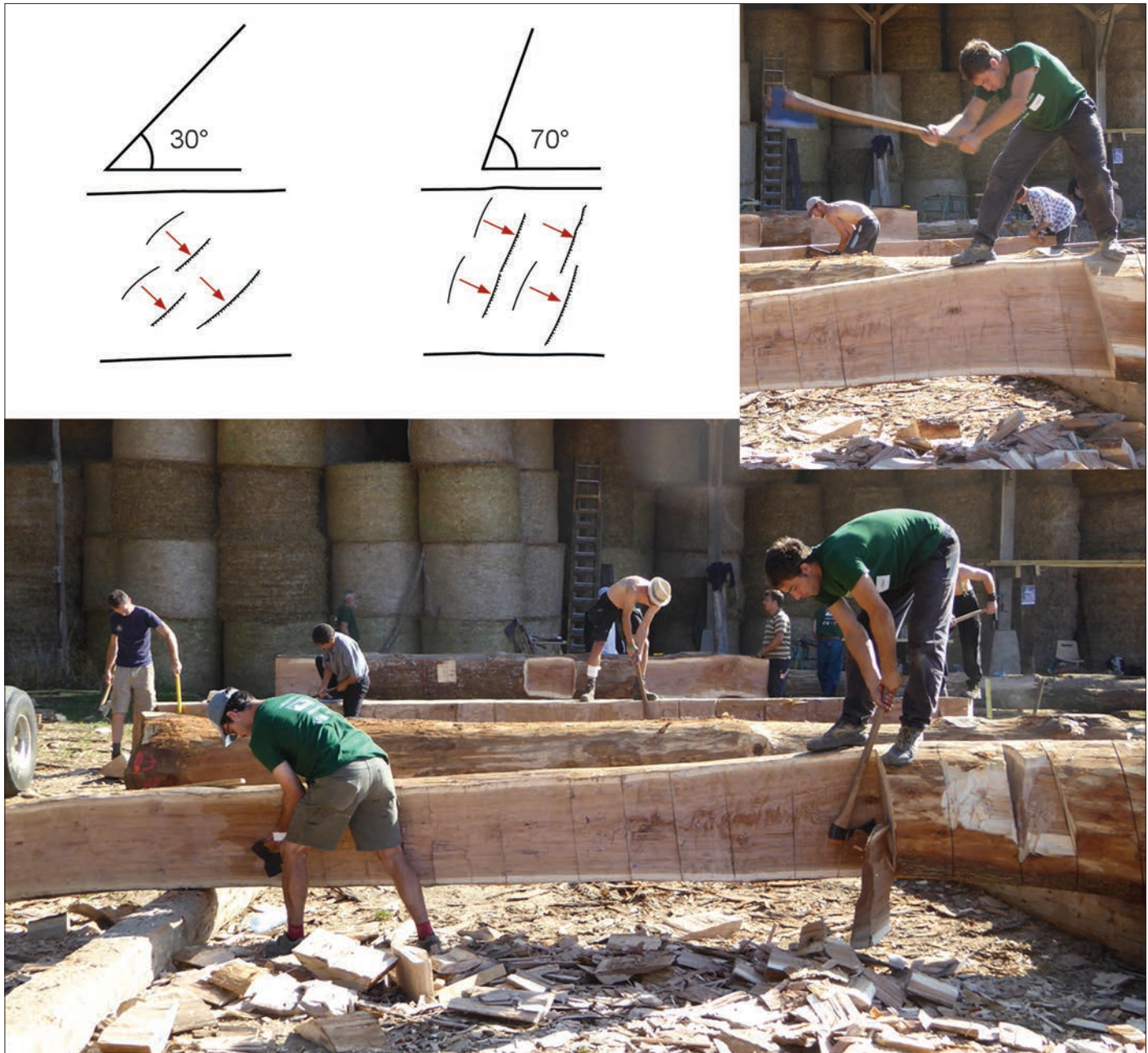
Fig. 3 – À gauche, taille au sol avec inclinaison des coups autour de 30°-40° et, à droite, position debout sur la poutre avec inclinaison autour de 60°-70°. Chantier de restauration d'une grange à Aclou (Eure) (clichés et DAO : F. Épaud).
