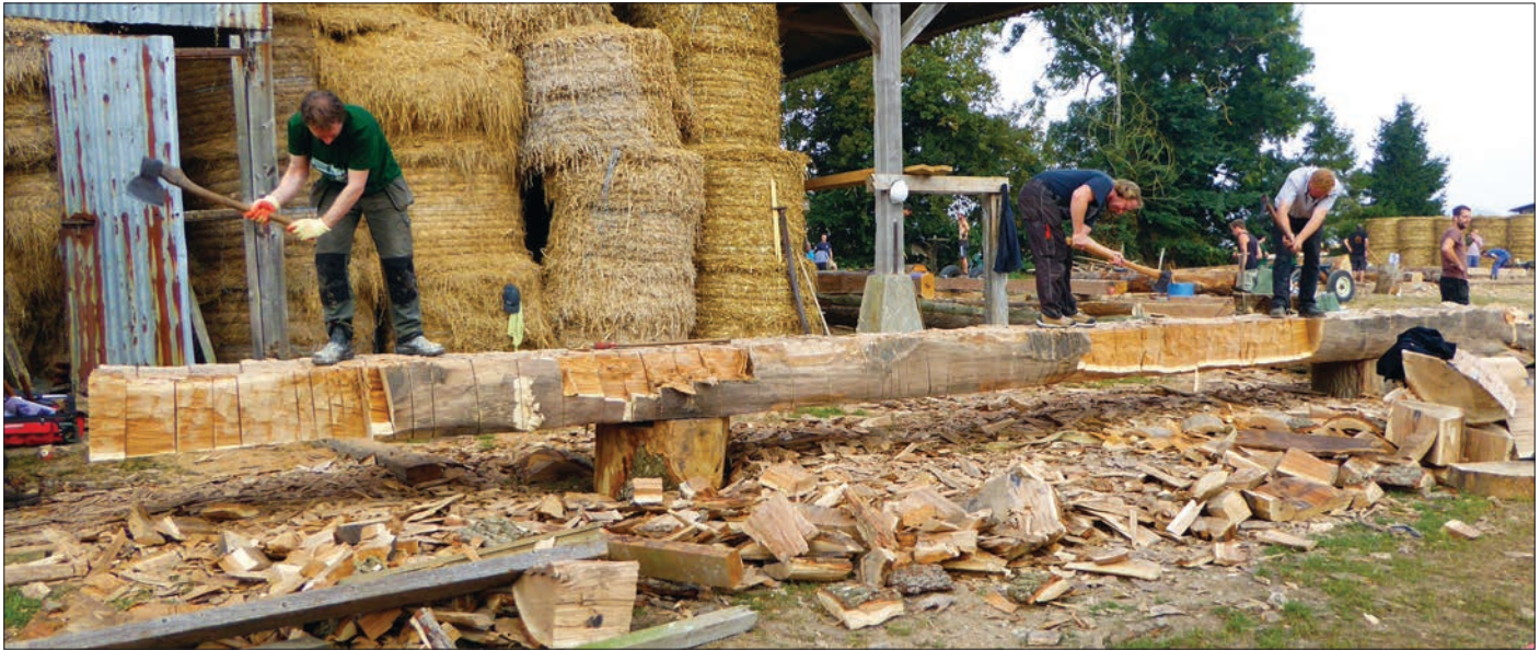
Fig. 6 – Taille d'une poutre de forte section à plusieurs équarrisseurs. Chantier de restauration d'une grange à Aclou (Eure) (cliché : F. Épaud).
