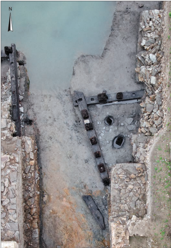
Fig. 7 – Vue aérienne des caissons n°s 12 (en cours de démontage), 8 et 9 (cliché : Kap Archéo, 2014).
