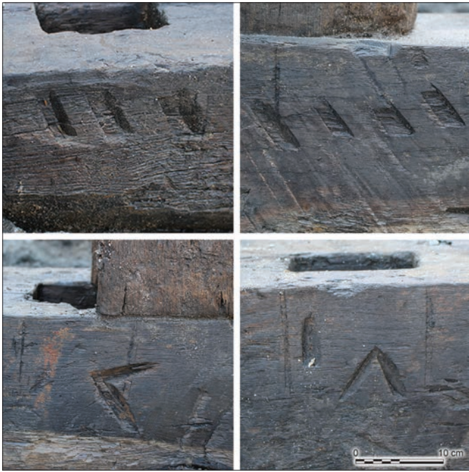
Fig. 4 – Marques numériques d'assemblage obtenues par enlèvement de matière à la hache sur le flanc externe de la sablière de façade du caisson n° 12 : de gauche à droite et de haut en bas, III, IIII, V et VI (clichés : X. Favreau, 2014).
