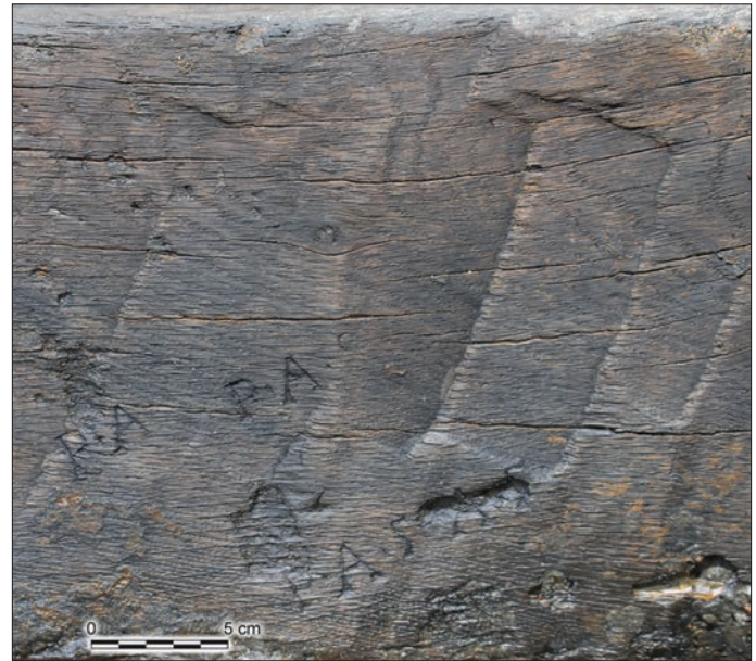
Fig. 5 – Détail des estampilles « P·A·S » et des traces laissées par l'équarrissage à la hache sur la face interne de la sablière de façade du caisson n° 12 (cliché : X. Favreau, 2014).
