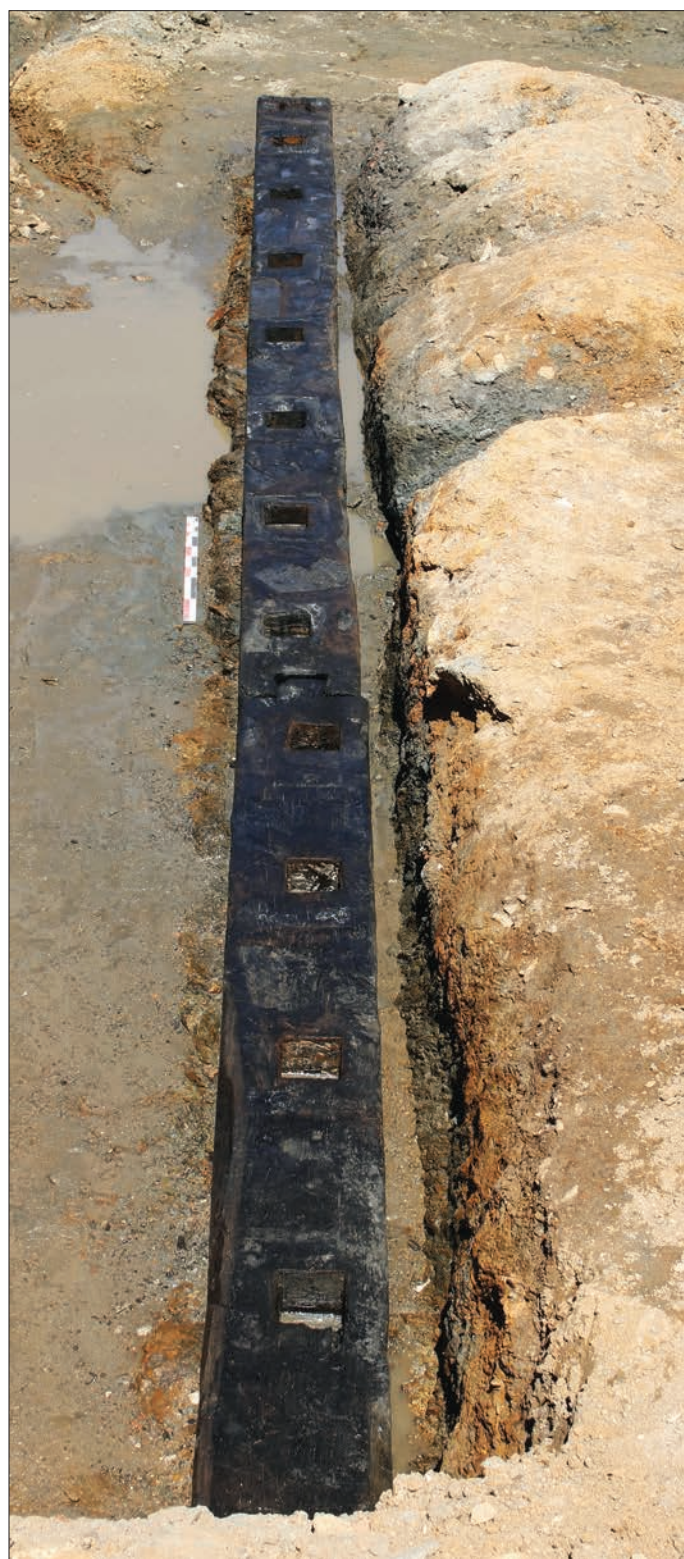
Fig. 10 – Vue des sablières SA44572 et SA44690, en place au fond de la tranchée de fondation conservée à droite du cliché (cliché: M. Yacger, 2016).
