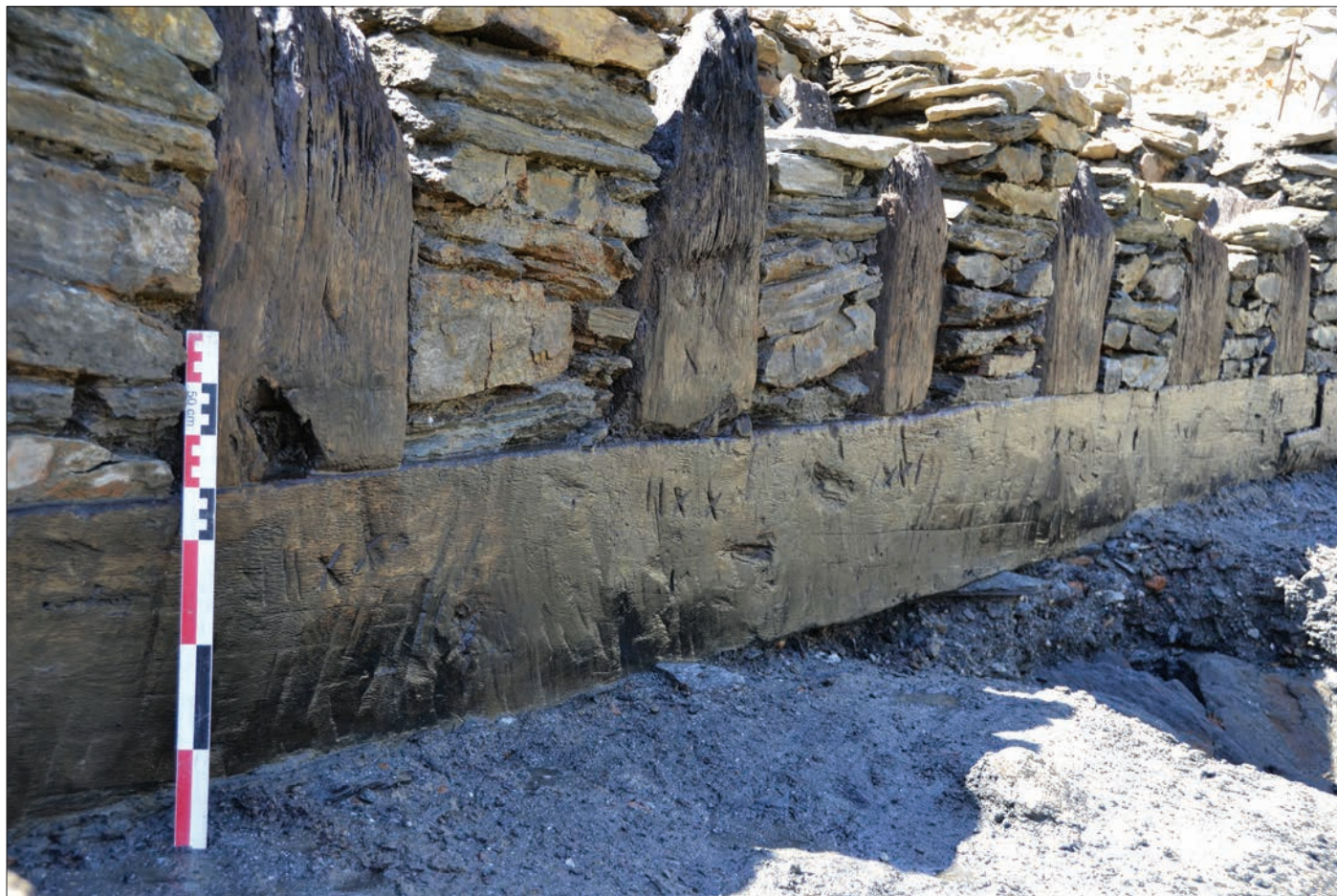
Fig. 4 – Détail de la façade à pan de bois septentrionale du caisson n° 9 après enlèvement des planches de bardage (cliché: J. Mouchard, 2011).
