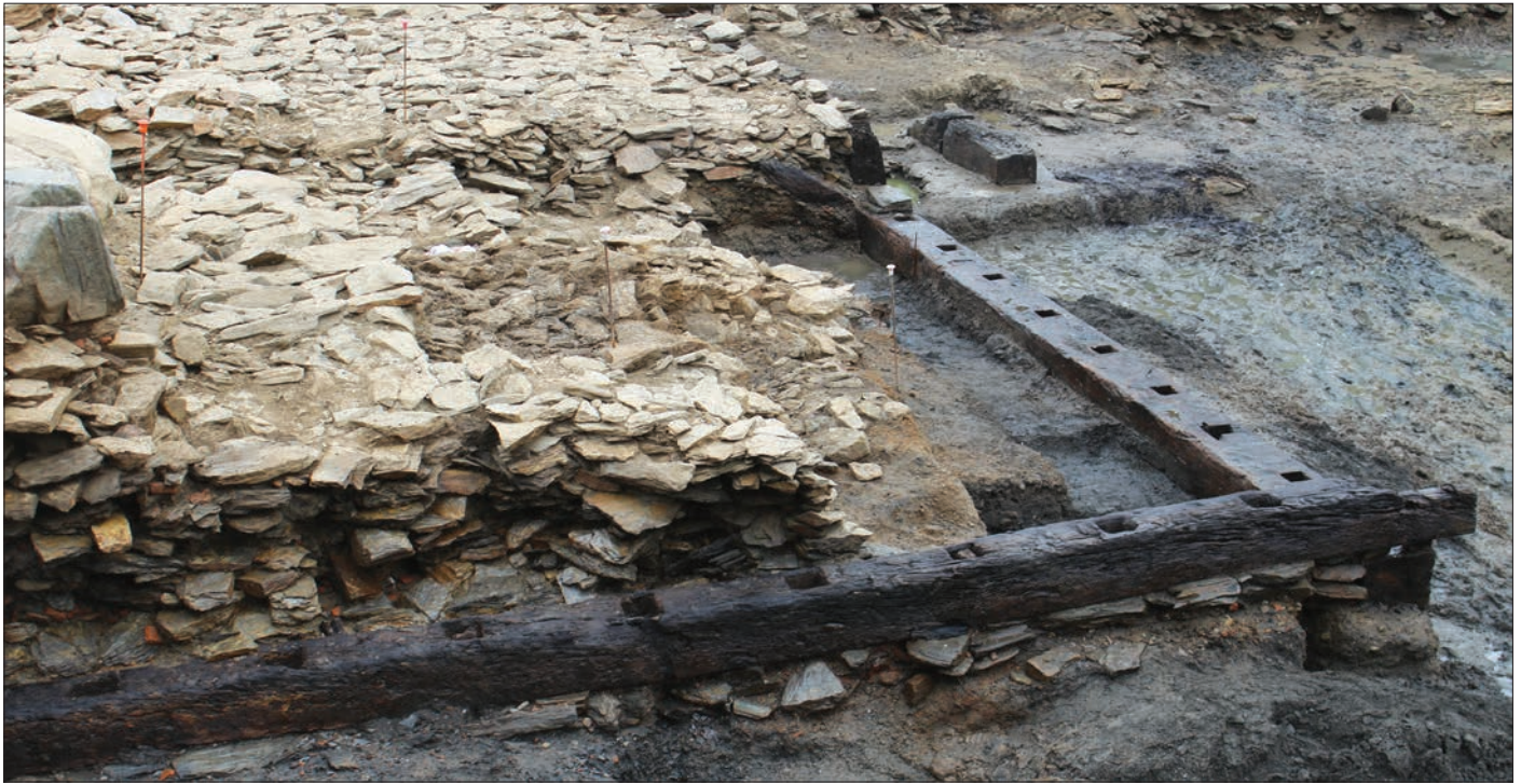
Fig. 8 – Vue, depuis l'est, de l'épais solin (Us 40930) sur lequel repose la sablière SA40028 (cliché: J. Mouchard, 2015).
