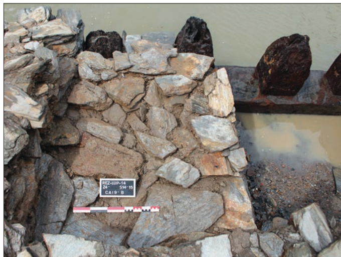
Fig. 18 – Maçonnerie en pierre sèche chaînée au hourdis de la façade nord (cliché: T. Maisonneuve, Service archéologique départemental de l'Aisne, 2014).
