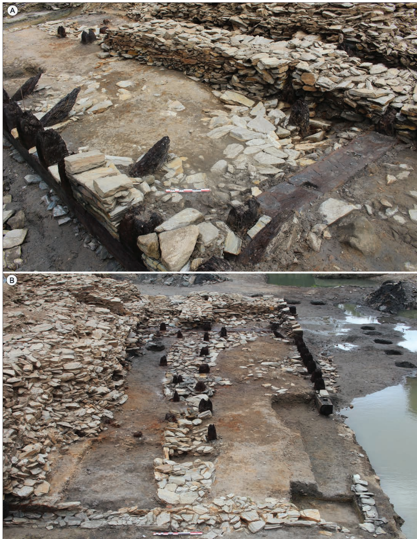
Fig. 20 – Armature interne du caisson. A , vue depuis le nord-ouest, avec, à l'arrière-plan, les poteaux associés au grand mur MR40972, en cours de démontage; B , vue depuis l'est, avec les poteaux encadrés par la base du mur MR40972, après démontage (cliché: J. Mouchard, 2015).
