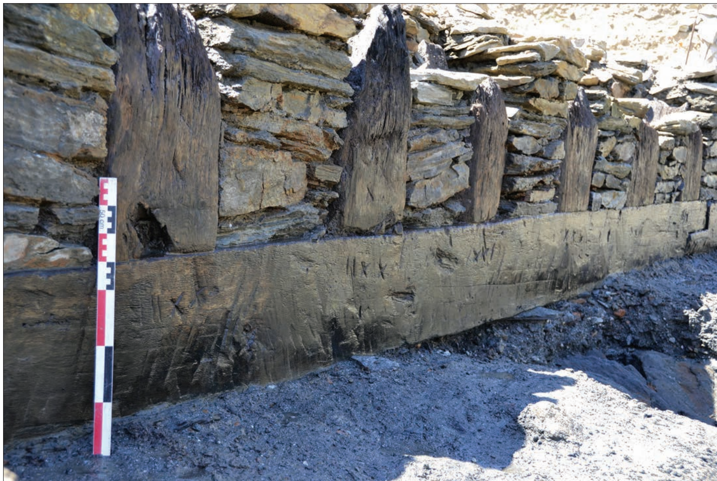
Fig. 16 – Détail de la façade à pan de bois septentrionale du caisson n° 9 après enlèvement des planches de façade (cliché : J. Mouchard, 2011).
