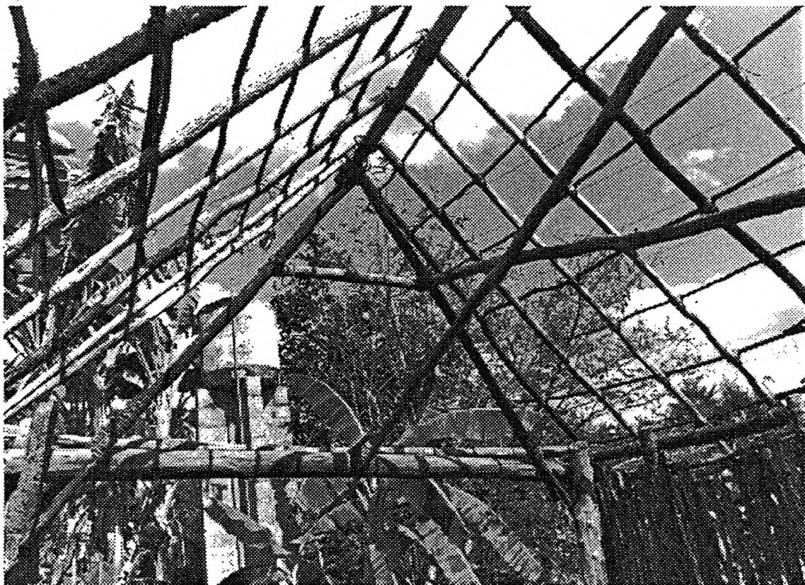
Photo 6 : Charpente de cuisine carrée: on notera les deux Belcho qui se croisent.
