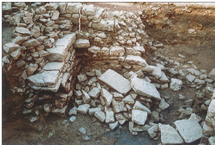
Fig. 5 – Poterne-embarcadère supposée du murus gallicus, vue vers le sud-ouest (cliché : P. Haut).
