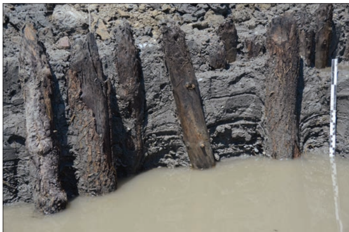
Fig. 15 – Pieux bruts utilisés pour stabiliser des niveaux de plage en aval au Castélou (cliché: J. Labussière, CNRS).
