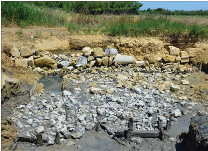
**Fig. 18** – À Mandirac, contre la digue qui est surélevée par l'accumulation de gros remblais de galets permettant la circulation. La palée nord, côté lagune, maintient les matériaux à l'aide de planches et de pieux bruts (cliché: C. Sanchez).
