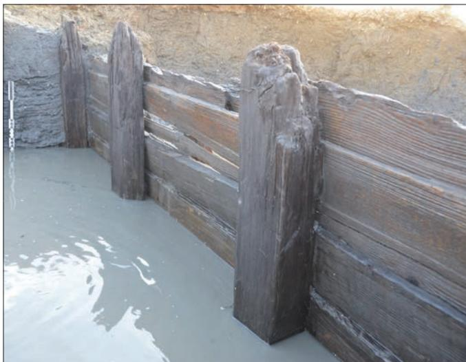
Fig. 7 – Palée en aval, au Castélou, ayant servi à maintenir les sédiments, puis comme fondation des niveaux de circulation au 1<sup>er</sup> s. apr. J.-C. (cliché: C. Sanchez, CNRS).
