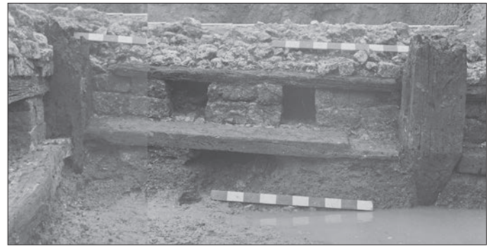
Fig. 10 – Détail du mur de terrasse sud (en 1976), avec assemblage et pieu appointé peu ou non enfoncé (soulevé par la pression de l'eau ?); l'angle sud-est de l'aménagement est à gauche, avec son poteau cornier (cliché : A. Ferdière).
