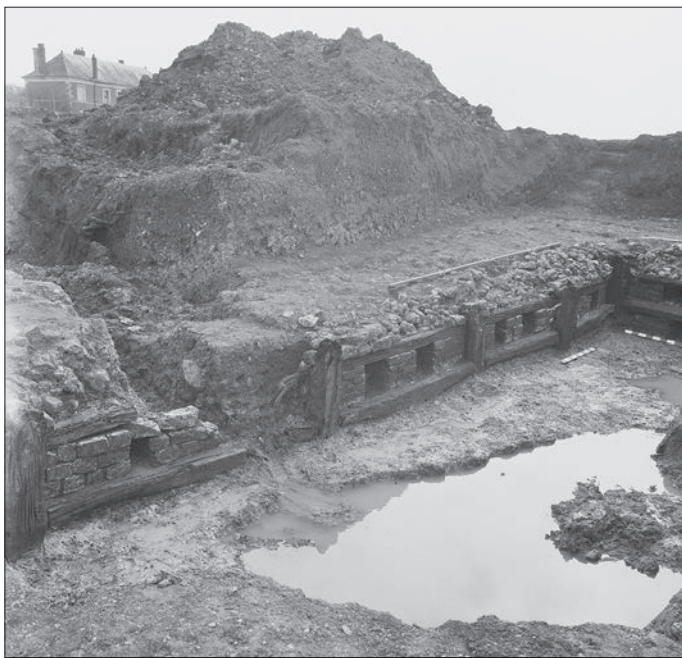
Fig. 9 – Quai dégagé (angle sud-est), vu du nord-est, avec poutres horizontales encadrant les barbacanes régulières, à la fin de la campagne de 1976 (cliché : A. Ferdière).
