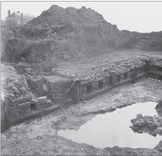
Fig. 9 – Quai dégagé (angle sud-est), vu du nord-est, avec poutres horizontales encadrant les barbacanes régulières, à la fin de la campagne de 1976 (cliché : A. Ferdière).
