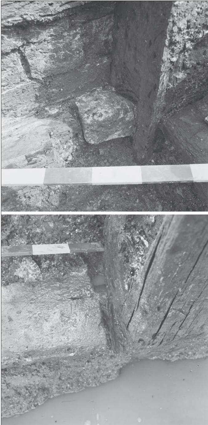
Fig. 12 – Deux exemples de cales entre les pieux verticaux et la première poutre horizontale (inférieure) à l'aide soit d'un moellon, soit d'une petite pièce de bois (coin) (clichés : A. Ferdière).
