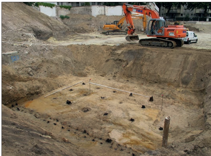
Fig. 8 – Vue générale des têtes de poteau après le décapage profond du caisson 1. La double rangée de piquets située au premier plan correspond à la limite du premier état de l'embarcadere, vue prise du sud-est (cliché : N. Fouillet, Inrap).
