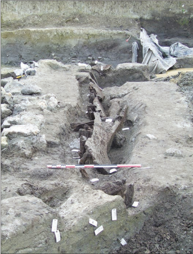
Fig. 10B – Vue d'ensemble depuis l'ouest de la base du caisson, état 3 (cliché : V. Duphil).
