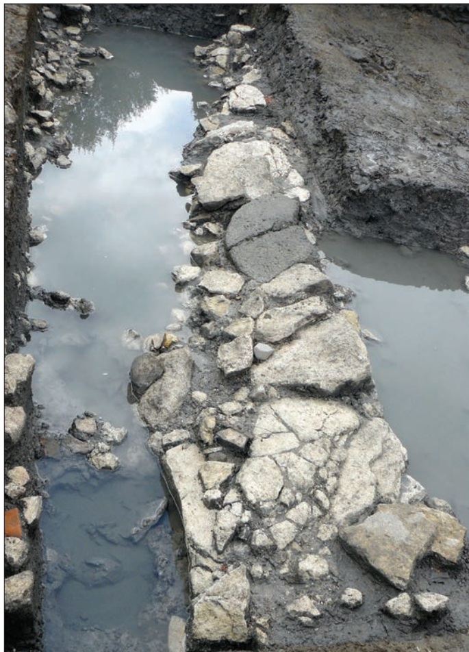
Fig. 7 – La partie est du mur de quai, effondrée dans le paléochenal. Le nord est à droite de la photo (cliché : C. Allinne).
