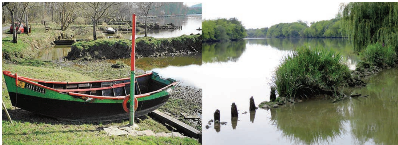
Fig. 12 – À gauche : le quai (premier plan) et les digues (arrière-plan) d'un bassin de Rasport à Saint-Étienne-d'Orthe (Landes). À droite : vue détaillée de la digue de fermeture du bassin (pieux de fondation et soubassement de blocs) (clichés : M. Allinne à gauche, C. Allinne à droite).
