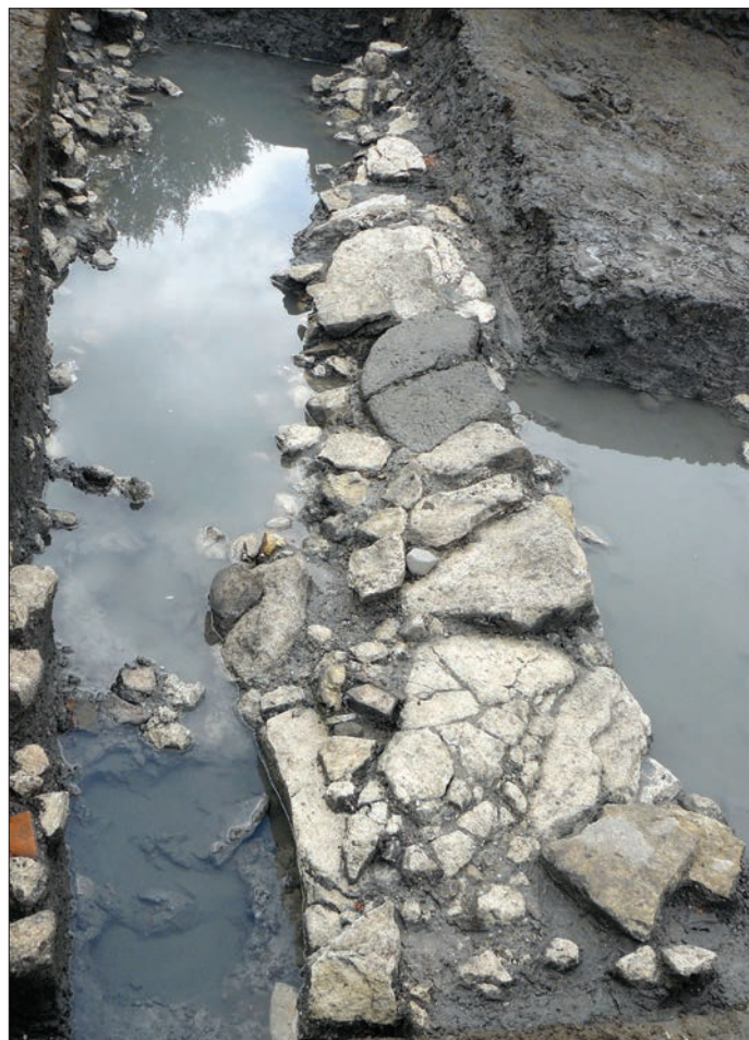
Fig. 7 – La partie est du mur de quai, effondrée dans le paléocheanal. Le nord est à droite de la photo (cliché : C. Allinne).
