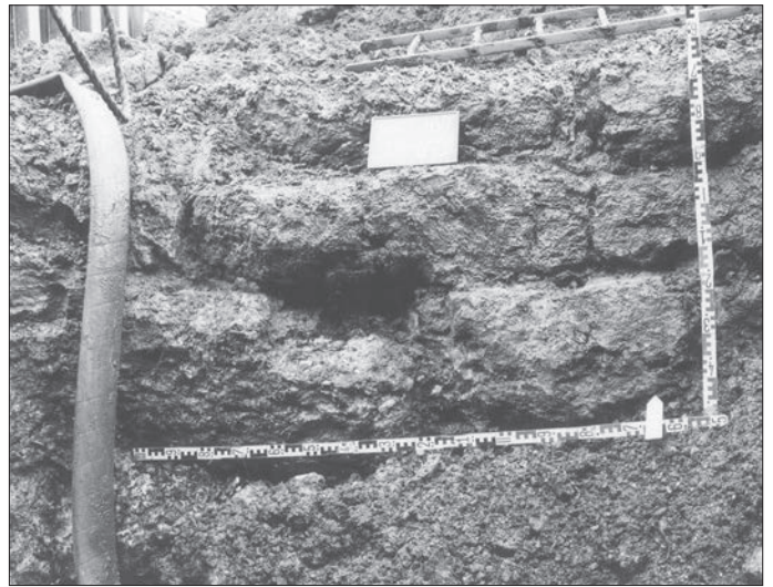
Fig. 13 – Place de la Haute-Vieille-Tour : mur du quai au sud de la place (cliché : J. Vavasseur, DRAC Haute-Normandie).
