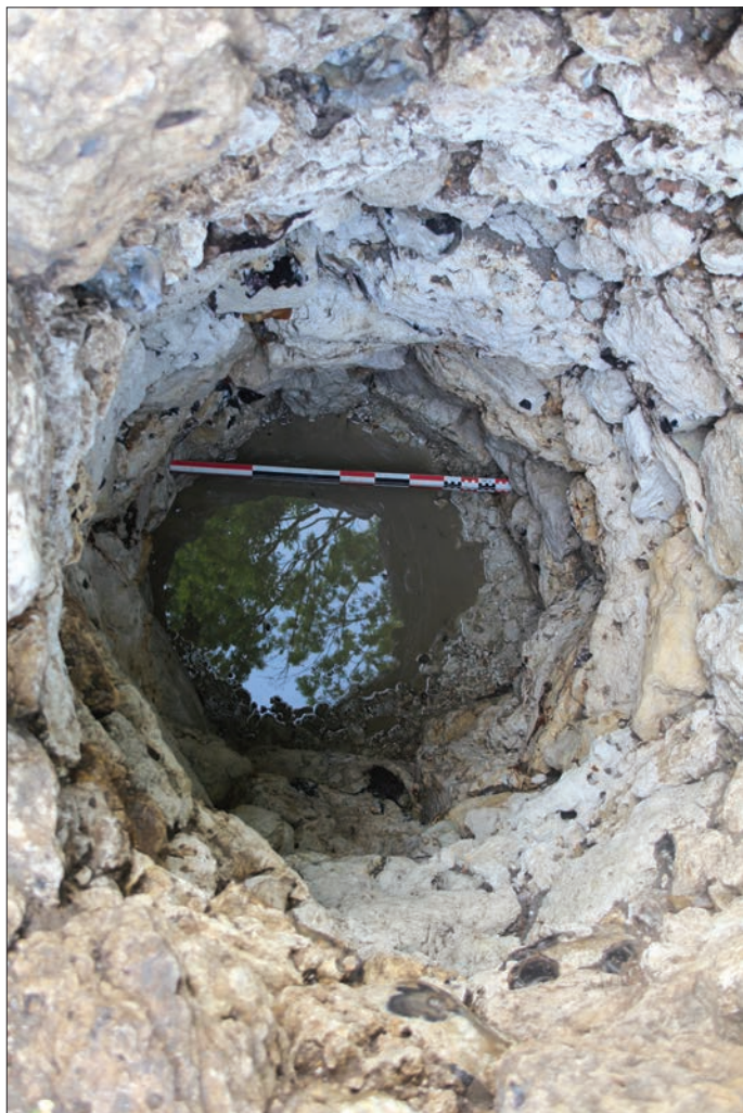
Fig. 18 – Intérieur maçonné du puits PT3485 (cliché : T. Le Cozanet, université de Nantes).
