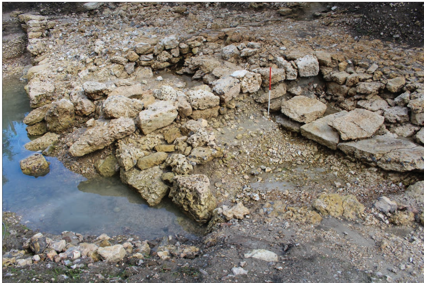
Fig. 13 – Vue, depuis le nord-ouest, du mur MR3372, quai plus récent se superposant au mur MR3553 du quai méridional (cliché : J. Mouchard).
