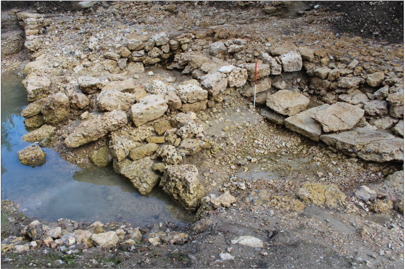
Fig. 13 – Vue, depuis le nord-ouest, du mur MR3372, quai plus récent se superposant au mur MR3553 du quai méridional (cliché : J. Mouchard).
