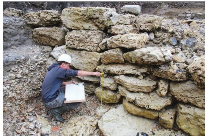
Fig. 15 – Vue rapprochée, depuis le nord, du mur de façade du quai septentrional (états 2 et 3) en cours de relevé (cliché : J. Mouchard).
