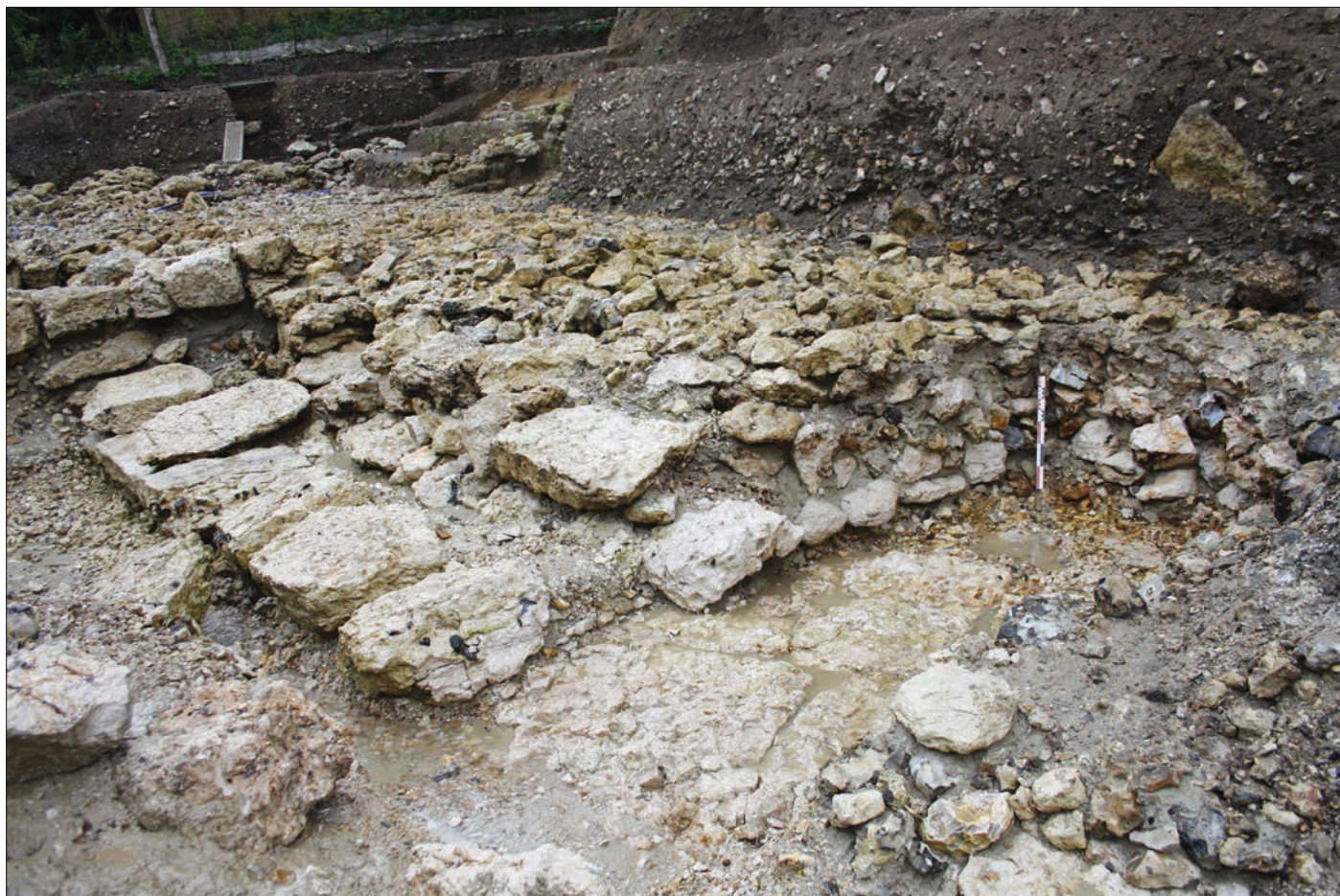
Fig. 12 – Vue, depuis le nord-ouest, du sondage SD2013-8. Le démontage partiel du quai permet d'apprécier ses fondations, à savoir un mur de façade et son blocage reposant sur le socle rocheux (cliché : J. Mouchard).
