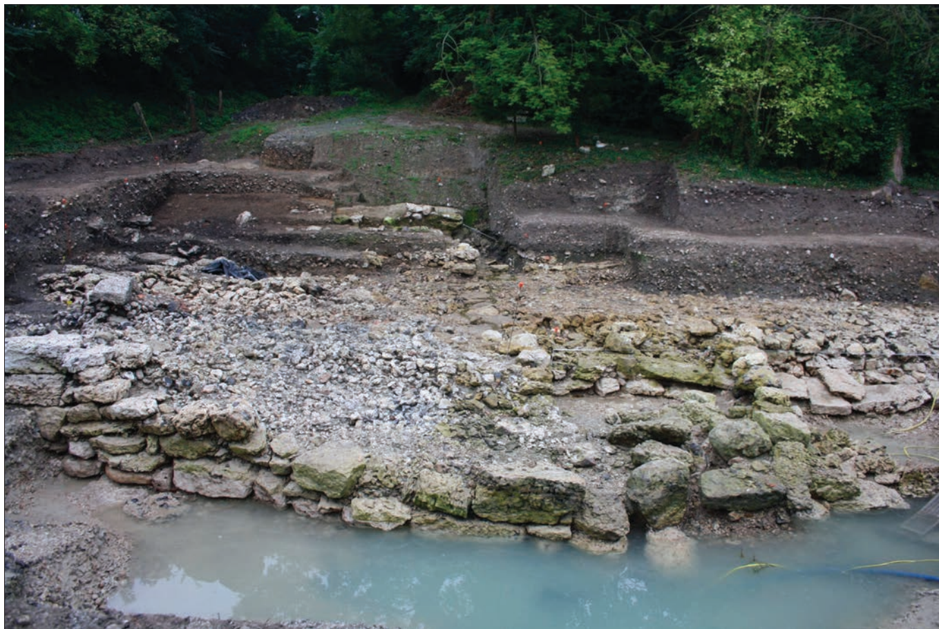
Fig. 14 – Vue, depuis le nord, du mur de façade du quai septentrional (cliché : J. Mouchard).
