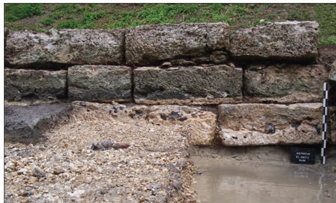
Fig. 6 – Digue/quai en calcaire à silex découvert dans les années 1970 et étudié lors de sondages en 2005. Affleurant sous la surface du terrain actuel, cet ouvrage imposant a été reconnu sur l'ensemble de la commune. Perçu dans un premier temps comme un possible aménagement antique, il est en fait bien plus récent, tardo-médiéval ou plus probablement de l'époque moderne (cliché : J. Mouchard).
