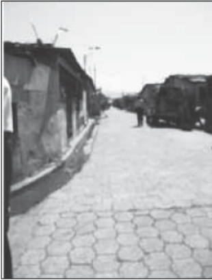
Rues rectilignes et pavées de Drouillard (avril 2011)
