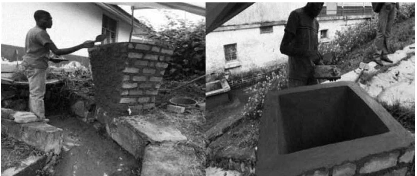
Figure 1 : Plate-forme expérimentale : la compostière
