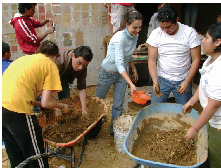
Figura 4. Ensayo de revocos en el Laboratorio de Materiales.
