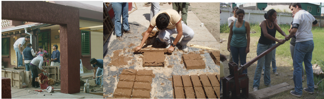
Figura 2. Práctica de campo. Elaboración de componentes constructivos: de tierra apisonada, de adobes y de bloques comprimidos
