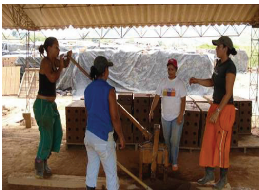
Fig. 1: Mano de obra comunitaria Vegachí 2010
