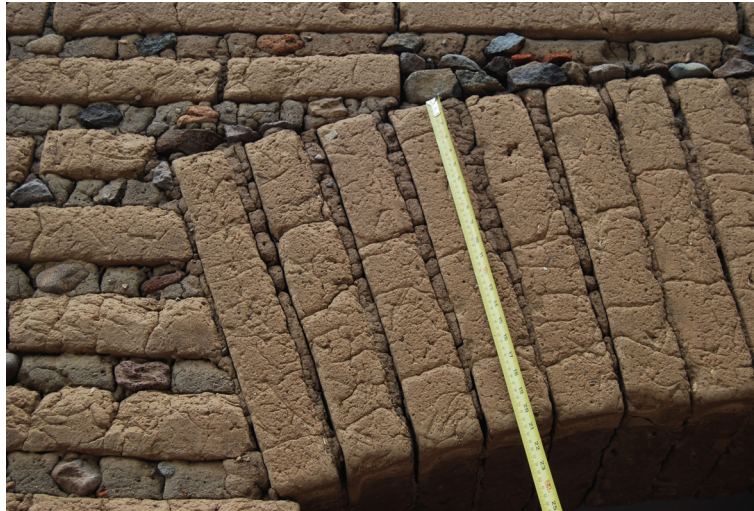
Figura 2. Levantamiento y documentación de edificios tradicionales.
