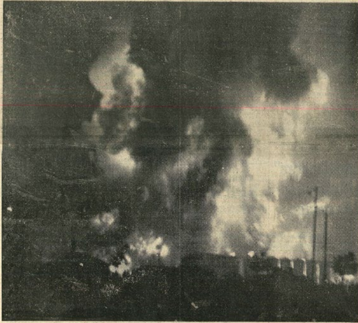
20 h. 20 : L'ensemble du dépôt pétrolier de Mourepiane n'est qu'un immense brasier. (Photo « Le Provençal »)
