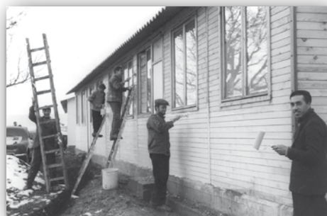
Construction des baraquements
