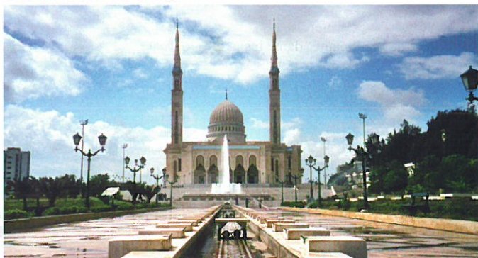
La mosquée, entrée principale
