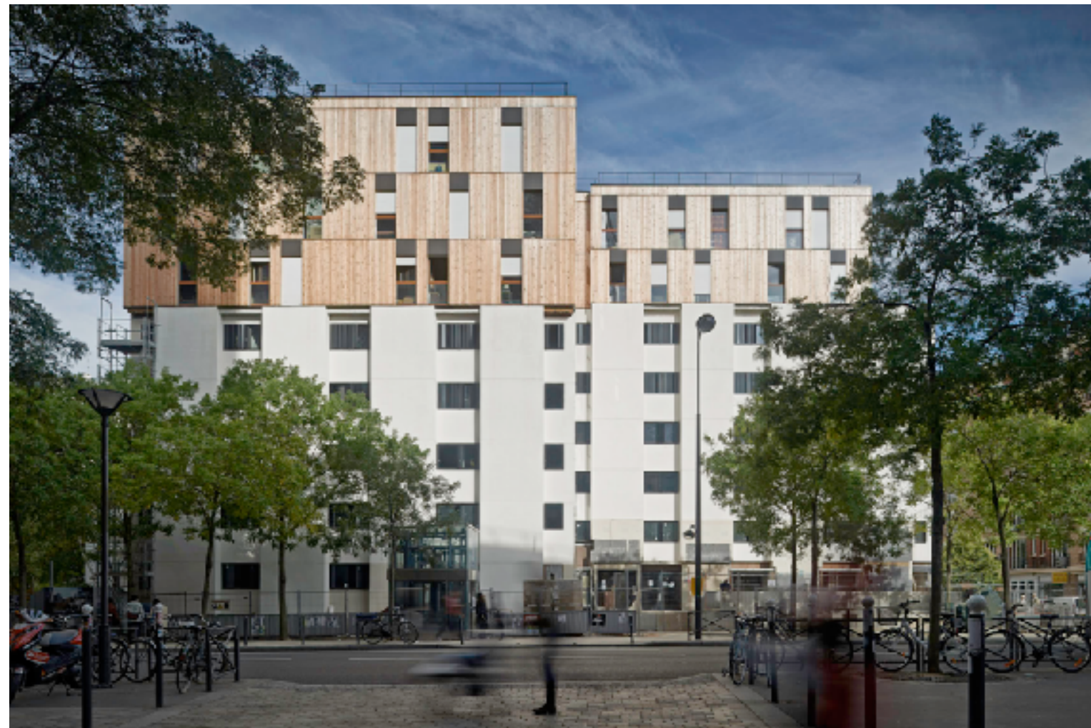
Surélévation en ossature bois de logements collectifs (Paris, FR)
