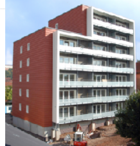
Le Toit Vosgien (St. Dié des Voges, FR) 2014, R+7, panneaux structuraux CLT + isolation paille
