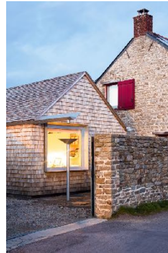
Extension de maison individuelle (Vigneux-de-Bretagne, FR)
