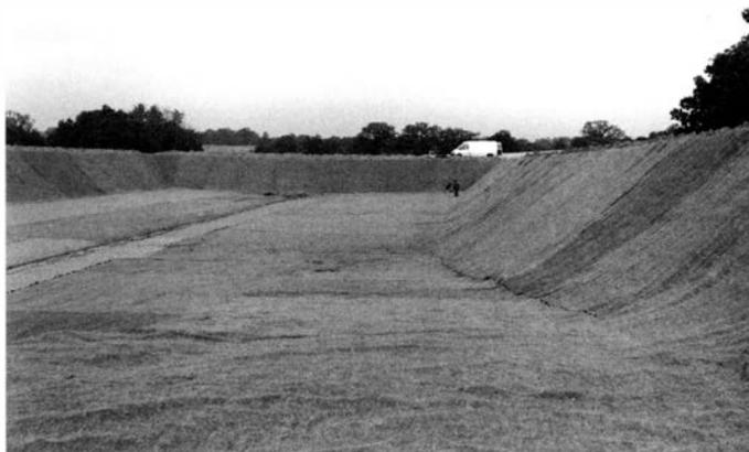
ve) en complément de la sécurité passive constituée par la couche argileuse naturellement présente sur le site. La géomembrane du DEG est une géomembrane Hydronap d'épaisseur 1 mm, en polypropylène. Le choix d'une telle géomembrane a été décidé pour les raisons suivantes :
