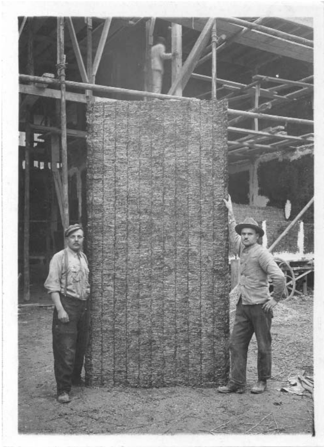
Une des quelques photographies du chantier du pavillon de l'Esprit nouveau conservées par Le Corbusier (FLC L2-13-43-001). Deux ouvriers manipulent un panneau de façade Solomite, en paille comprimée.
