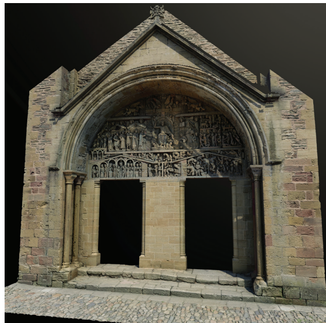
Fig. 3. Conques, Sainte-Foy : assemblage de scans de la façade sculptée (© Arts et Métiers ParisTech, HeSam).
