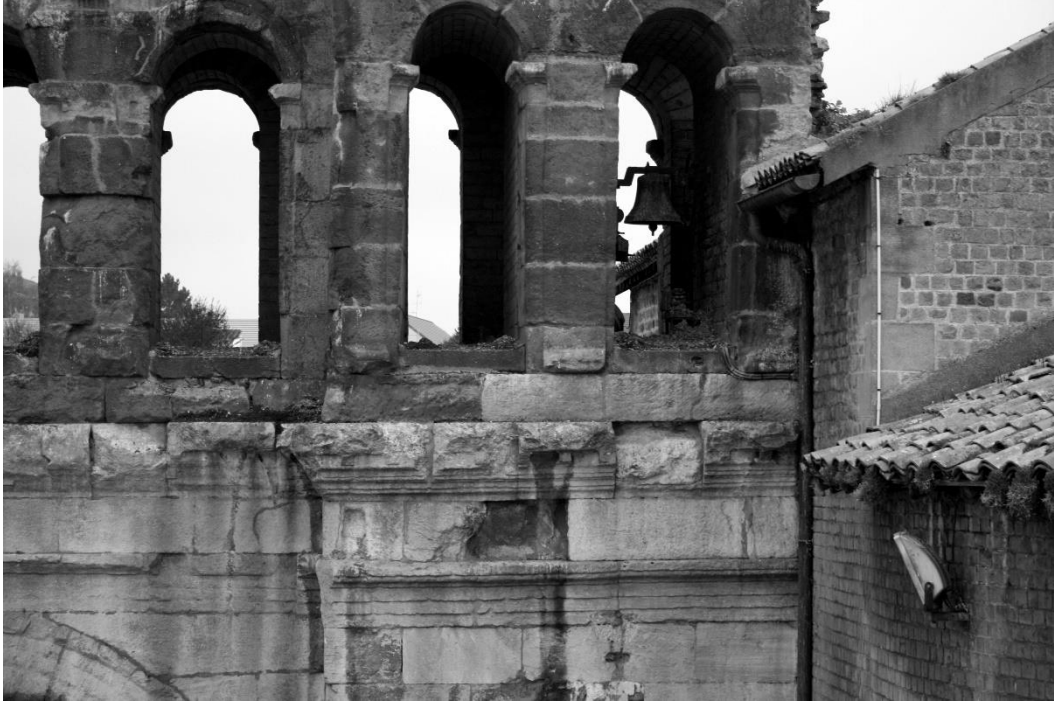
Fig. 6. Façade côté campagne de la porte Saint-André : au-dessus de la corniche médiane, deux blocs de calcaire oolithique de Fontaines (construction initiale) et blocs de grès arkose (réfection ultérieure).
