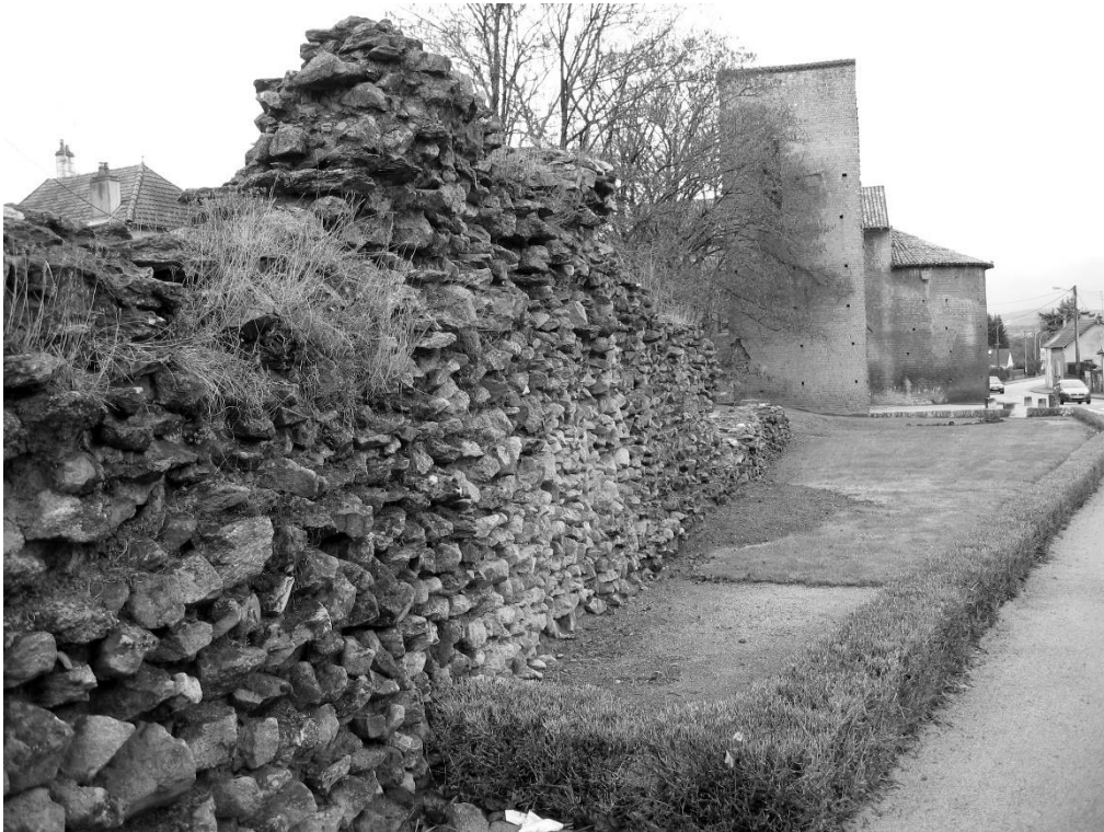
Fig. 7. Tronçon de mur de courtine au sud de la porte Saint-André : blocage composé de mortier de chaux et de nombreux moellons de granite à deux micas
