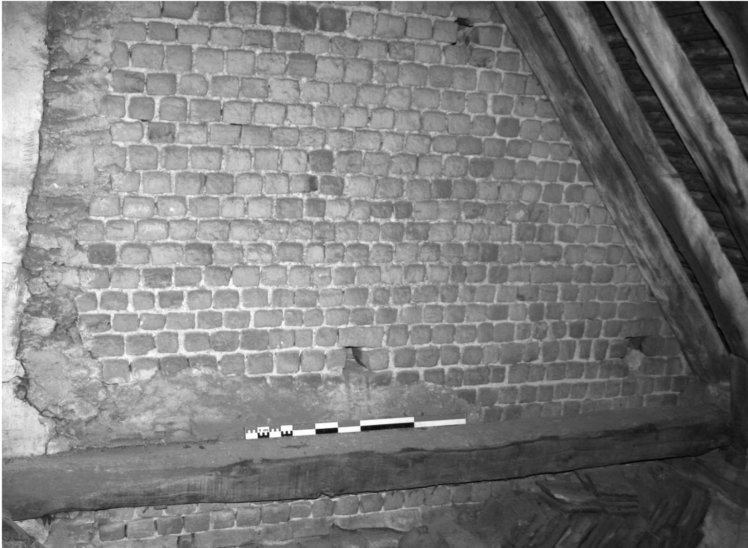
Fig. 8. Mur nord de la tour de flanquement sud de la porte Saint-Andoche : parement extérieur composé de moellons de grès fin du Rhétien.
