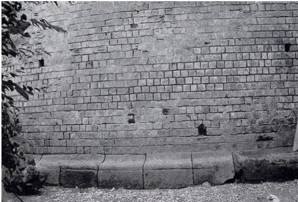
Fig. 5. Tour de flanquement nord de la porte Saint-André : soubassement mouluré en grès arkose et élévation en petit appareil de grès fin du Rhétien (cl. Duval y Quoniam 1963: 169).
