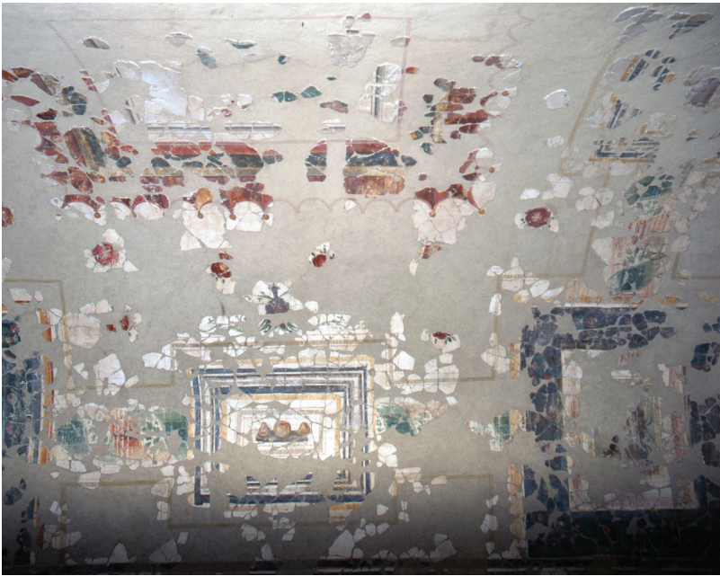
Fig 6. Avenches, insula 10, voûte de pièce sur hypocauste (cl. A. Barbet).
