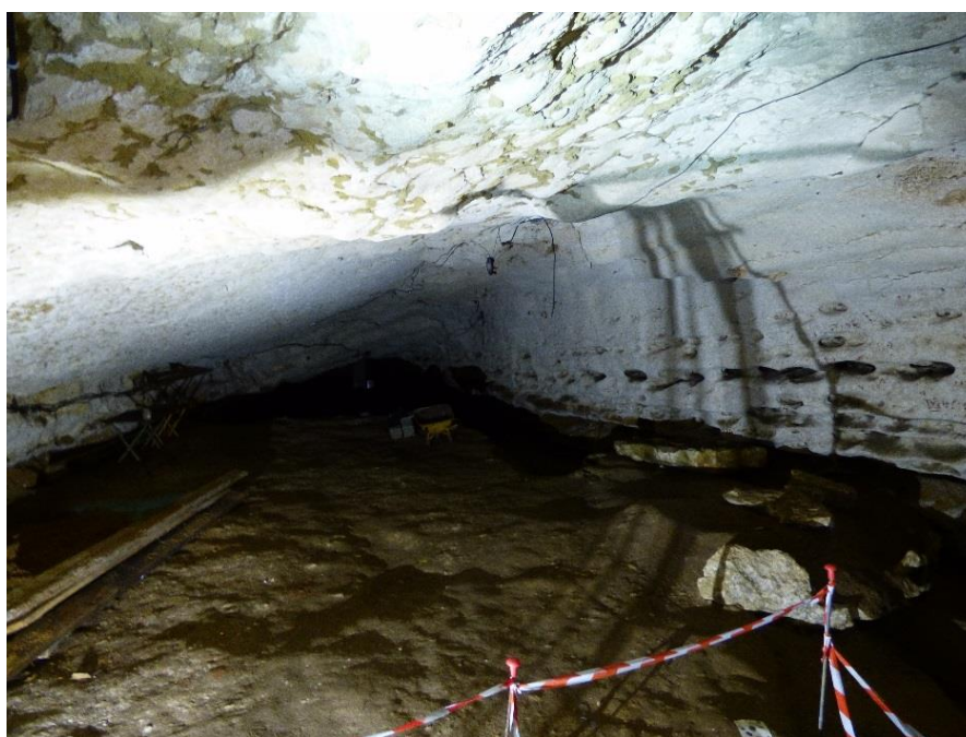
Photo 1, vue générale des encoches et parois de la cavité
