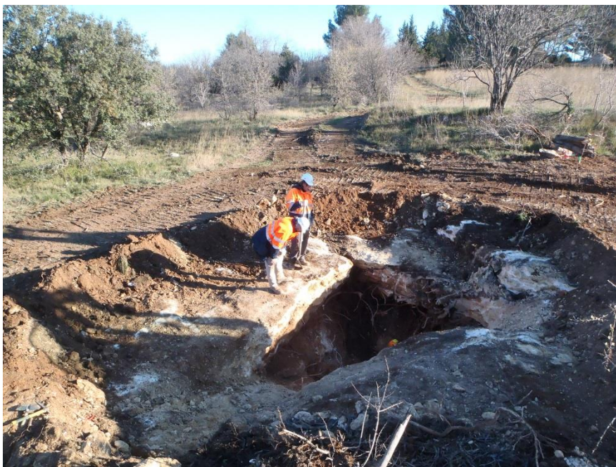
Figure 5 : Ouverture de la partie supérieure de la cavité (cliché L. Bruxelles)
