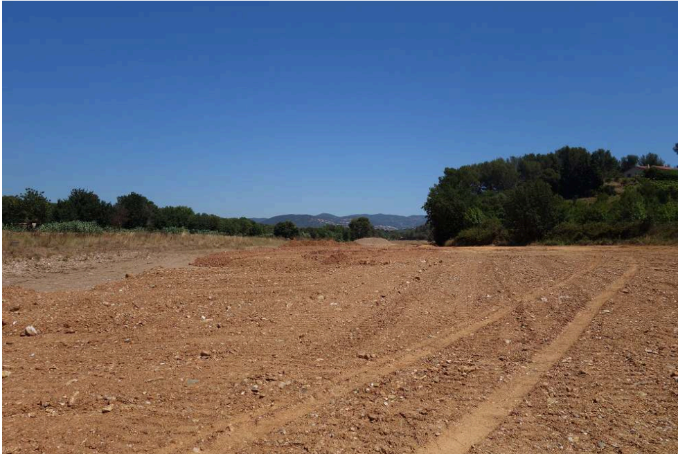
Figure . Remblais et reconstruction de la parcelle emportée par les crues de 2014
