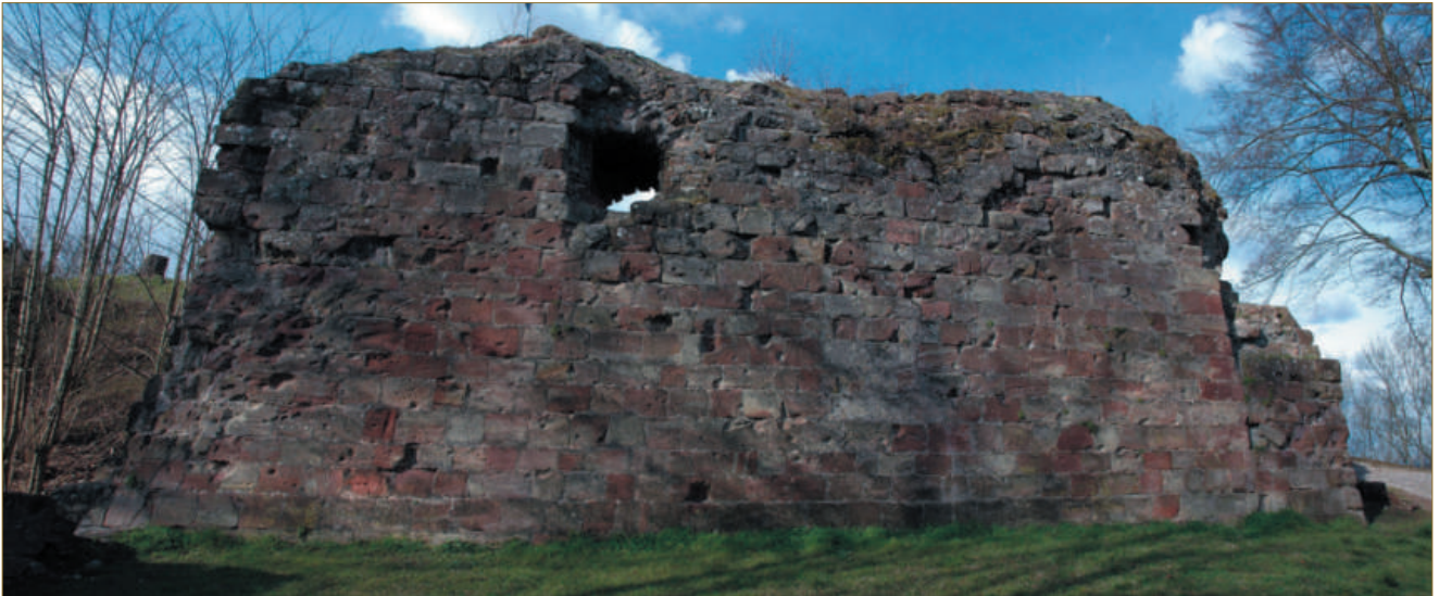
Figure 4 : Élévation extérieure sud (cliché C. Moulis).
