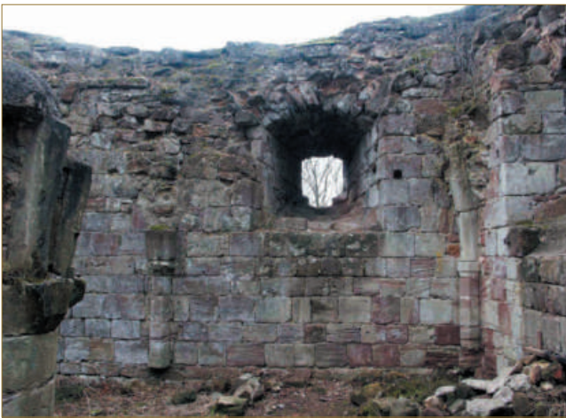
Figure 5 : Élévation intérieure sud (cliché C. Moulis).
