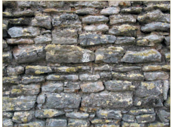
Figure 22 : Couche de mortier épaisse marquant un niveau de réglage, parement extérieur ouest (cliché C. Moulis).
