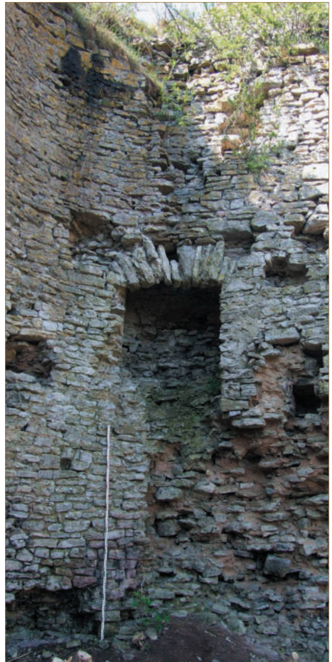
Figure 8 : Cheminée encastrée de l'élévation intérieure ouest (cliché C. Moulis).
