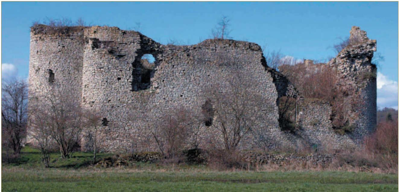
Figure 16 : Élévation extérieure est (cliché C. Moulis).
