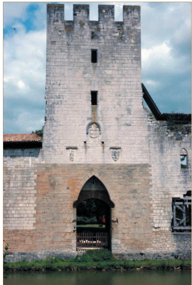
Figure 3 : Élévation sud-ouest, face aux douves (cliché C. Moullis).
