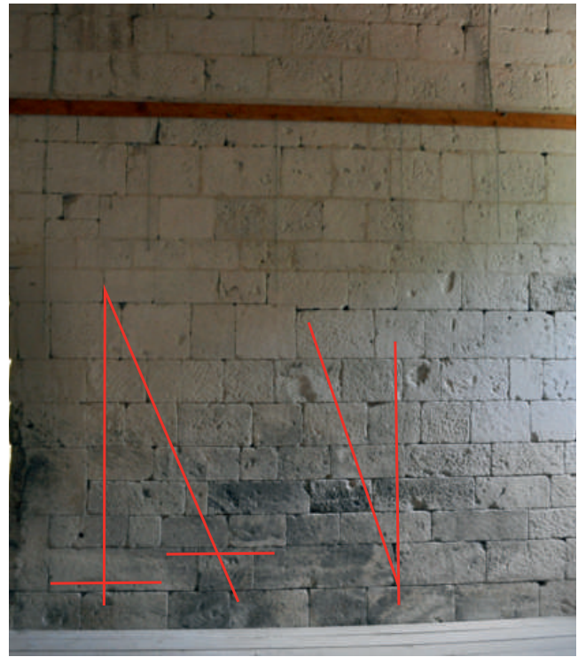
Figure 17 : Traits préparatoires de la salle des traits (cliché C. Moulis).
