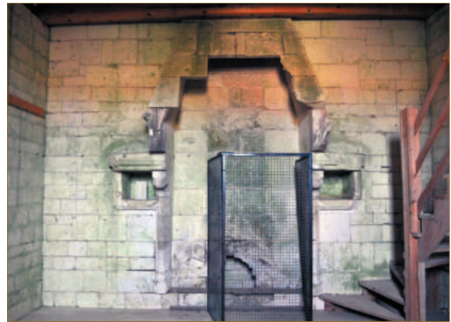
Figure 9 : Cheminée du second étage (cliché C. Moulis).
