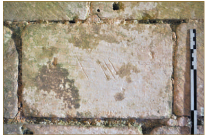
Figure 20 : Marque de pose petite et soignée (XIII), en comparaison de celles plus grossières (cliché C. Moulis).
