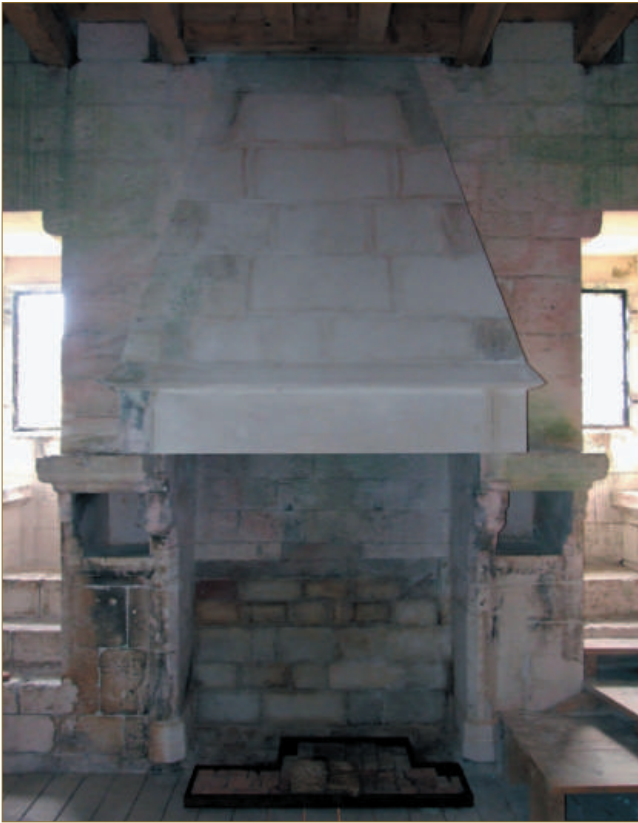
Figure 7 : Cheminée du premier étage (cliché C. Moulis).
