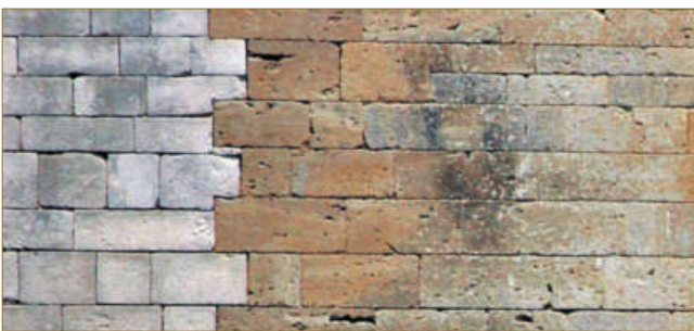
Figure 13 : Les deux types de calcaires employés dans la construction (cliché C. Moulis).
