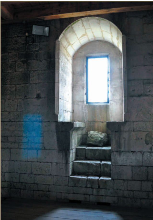
Figure 8 : Fenêtre à coussièges du second étage (cliché C. Moulis).
