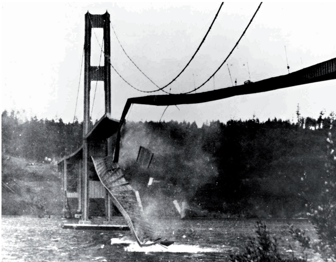
Effondrement du pont de Tacoma ("galloping Gertie") en 1940 The Tacoma Bridge ("Galloping Gertie") collapse in 1940.
