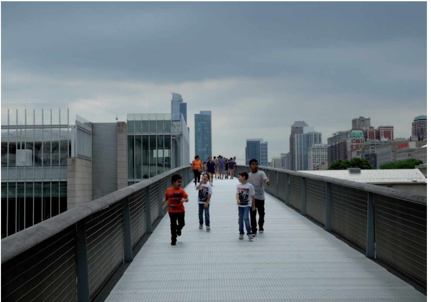
Nichols Bridgeway à Chicago, Renzo Piano architecte - photo LM
