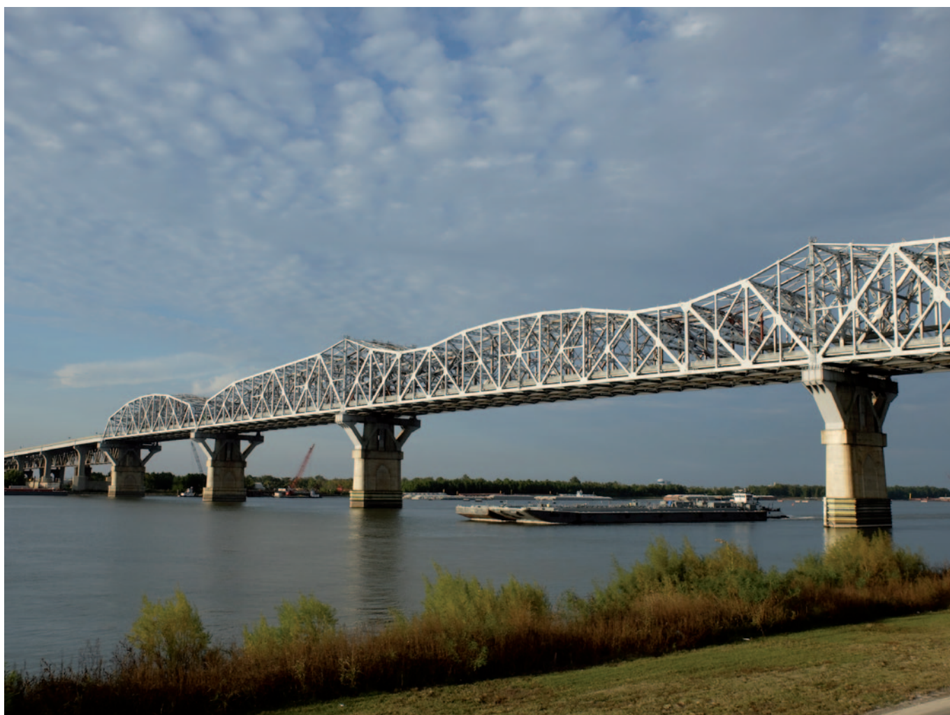
ci-dessous: un modèle sophistiqué de très grande portée par assemblage d'éléments métalliques Huey P Long bridge sur le Mississippi à la Nouvelle Orléans - photo LM 2017
